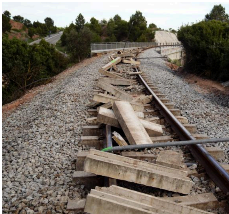
Un tram de les vies afectades ■ SCN.
